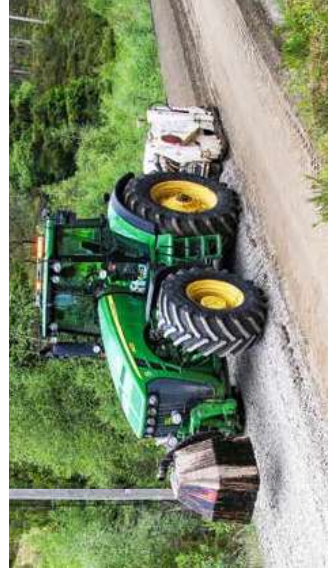
Blandingsfresen i arbeid. Pukkstein er lagt ut oppå den homogene massen fra knusefresen. Det ferdigblandete bærelaget ligger pent liggende der maskinen har kjørt over.
