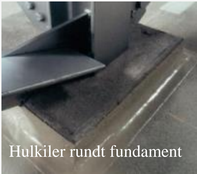
Figur 4.5 Opphøyd fugeløsning på flatt dekke når fuger etableres mellom elementer.
