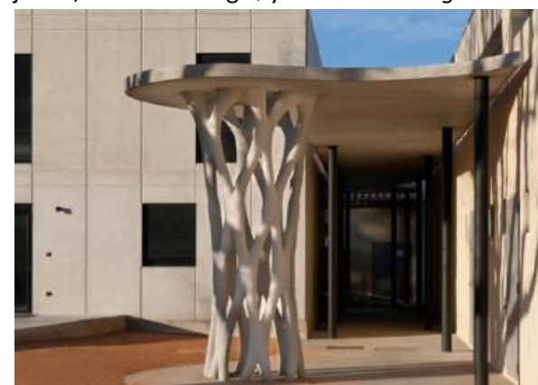
Figur 2: Topologioptimalisert søyle
